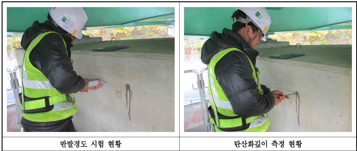
【사진 19.4.1】 콘크리트 내구성조사 현황
