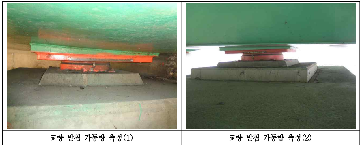
【사진 19.3.15】 교량받침 이동량 측정
