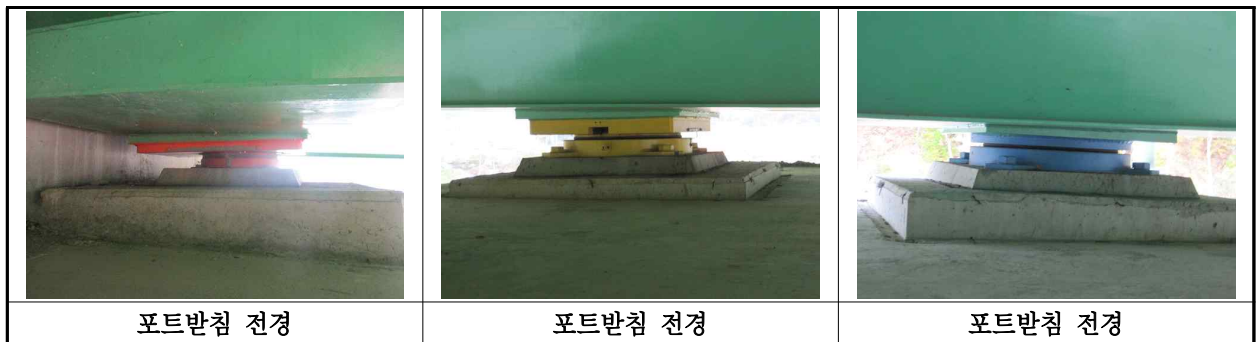
【사진 19.3.12】 교량받침 전경
