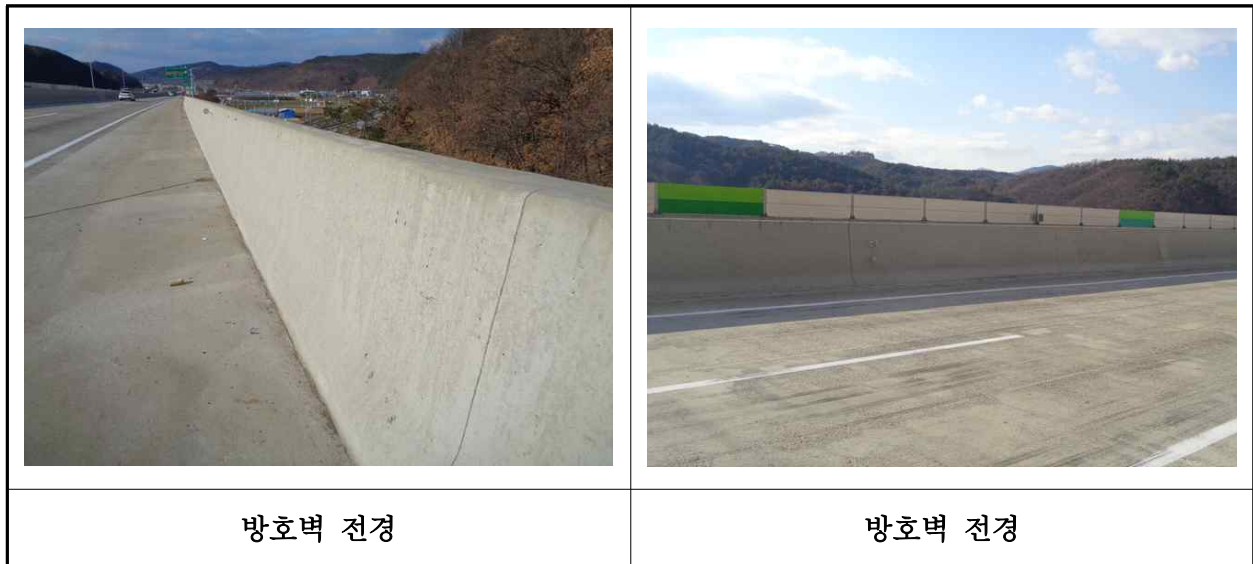
【사진 19.3.23】 방호벽 및 중앙분리대 전경
