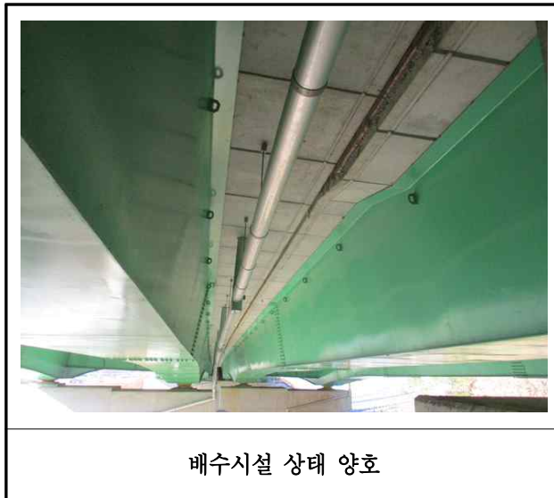
【사진 19.3.45】 배수시설 손상현황
