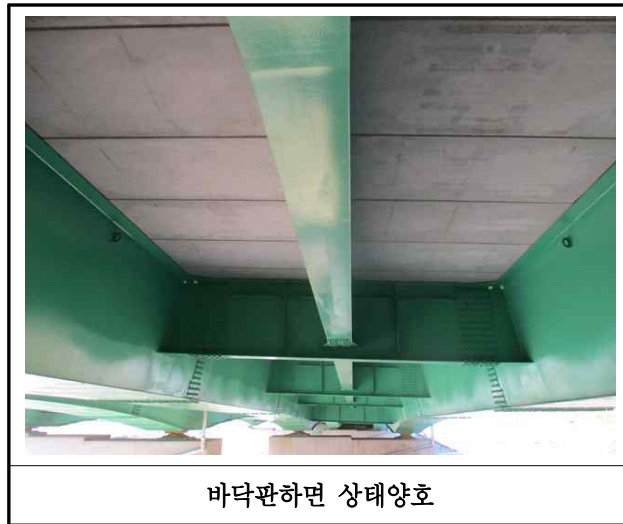
【사진 19.3.3】 바닥판하면 손상현황
