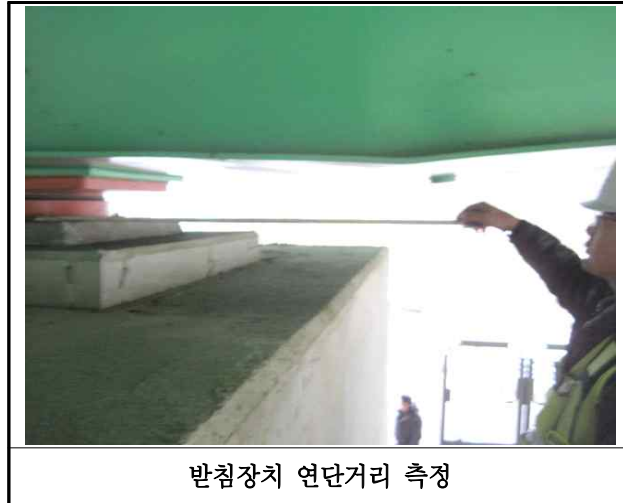
【사진 19.3.14】 교량받침장치 연단거리측정
