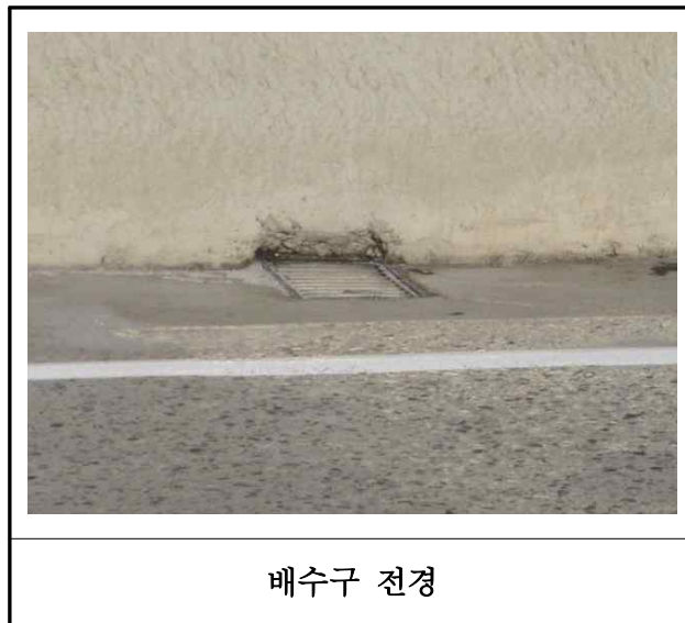
【사진 19.3.44】 배수시설 전경
