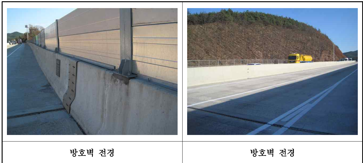
【사진 19.3.46】 방호벽 및 중앙분리대 전경
