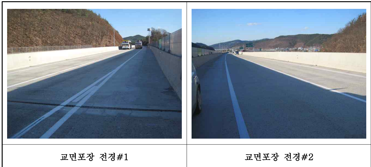
【사진 19.3.42】 교면포장 전경
