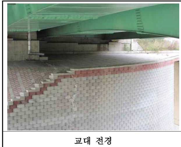
【사진 19.3.8】 교대 전경
