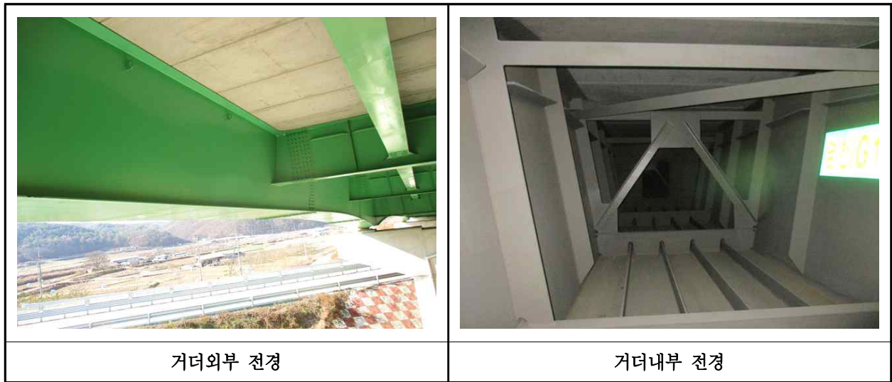
【사진 19.3.27】 거더 전경
