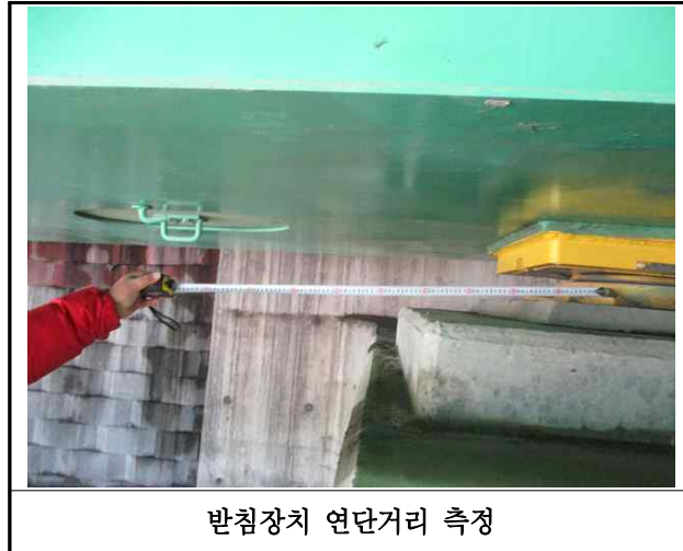
【사진 19.3.37】 교량받침장치 연단거리측정
