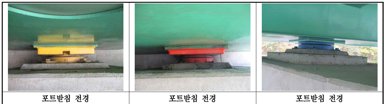
【사진 19.3.35】 교량받침 전경
